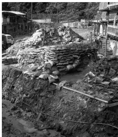
Foto 67: Exposición falsamente construida.
