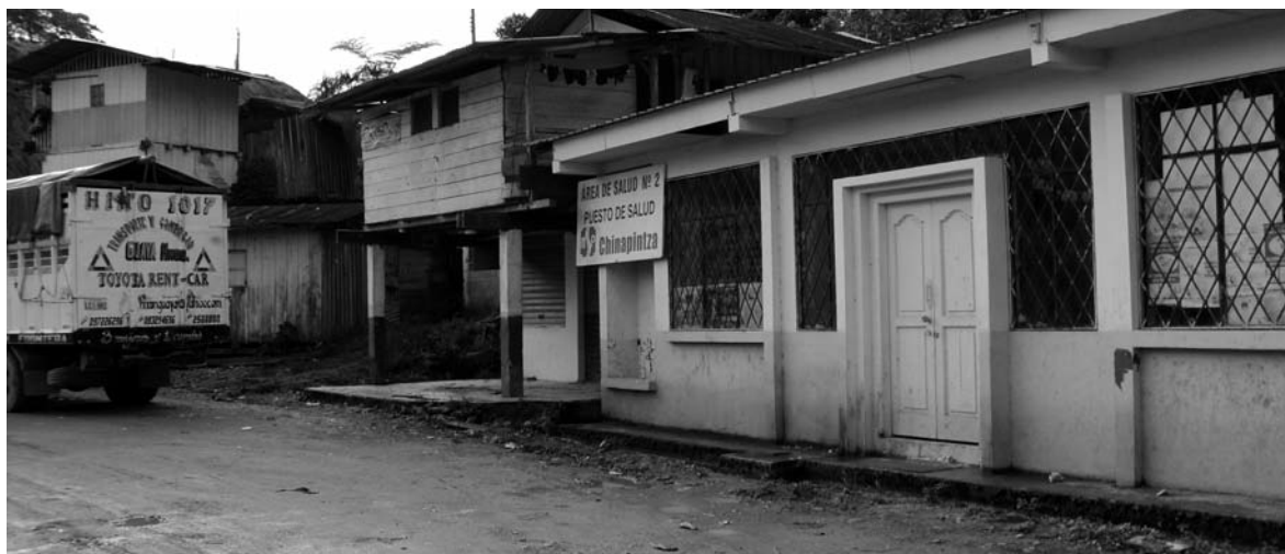
Foto 35: Recinto Puerto Minero de Chinapintza
